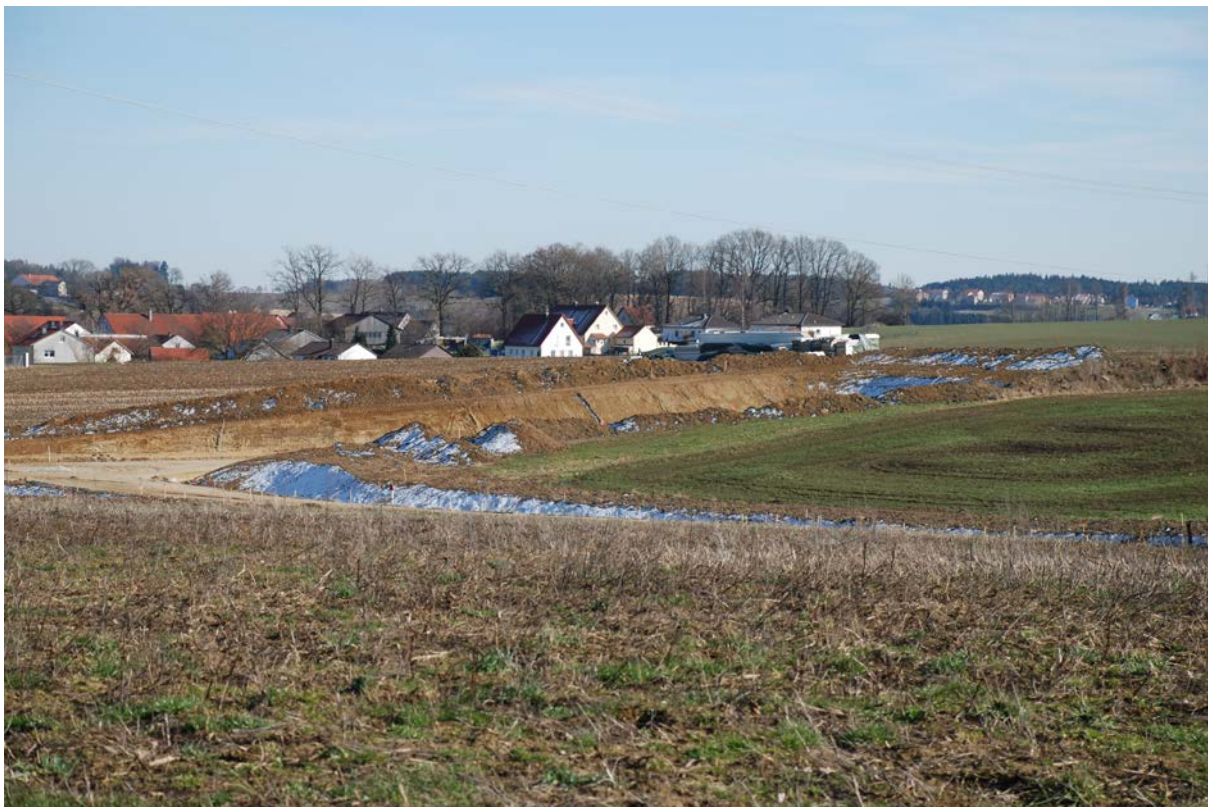
Bild 6: Massive Erdbewegungen im Gewerbepark – trotz fehlender Planungssicherheit hat der Markt erste Maßnahmen durchgeführt
